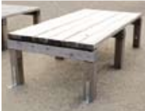
束と束のピッチは 900mm (デッキ板厚 40mm の場合)
