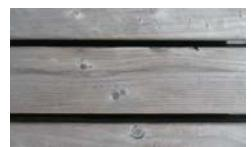
例右: リフォームのため充分な床高が取れなかったため目透かしは12mm、デッキ材の厚み40mm、杉の赤身材を使うなどの工夫を重ねています。
